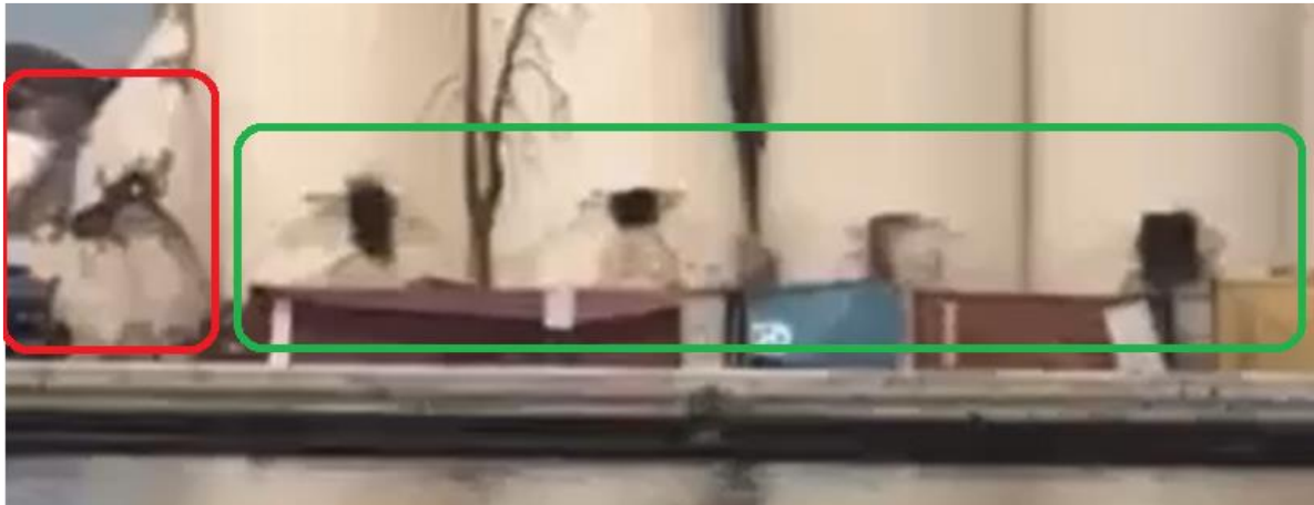
Figure 15. انهيار أول صومعتين من المجموعة الشمالية (بالعلامة الحمراء) عند موضع الثقب الموسع وانتشار التشققات انطلاقاً من الثقب في باقي الصوامع (بالعلامة الخضراء)
