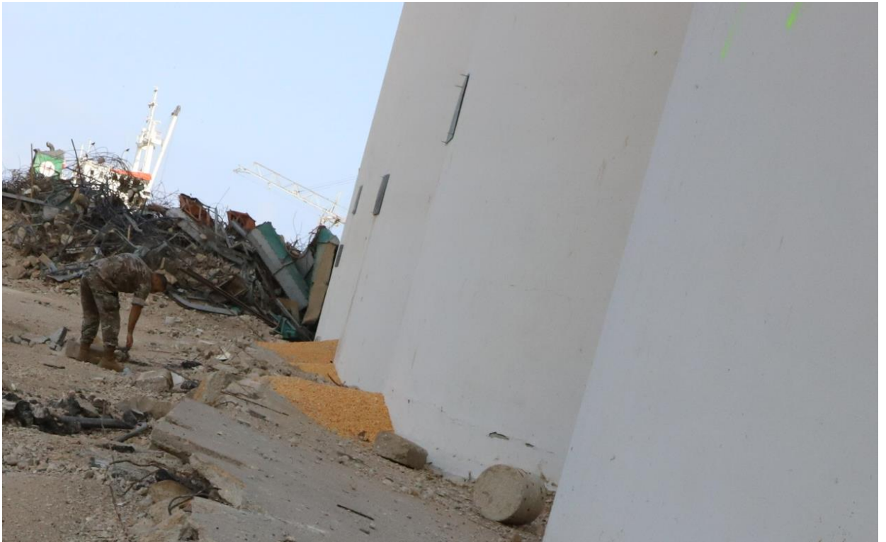
Figure 6. ثقوب التفريغ الأساسية بعد اغلاقها بألواح معدنية.
