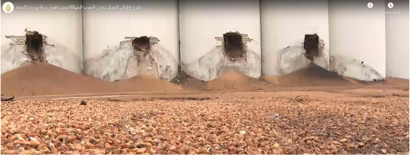
Figure 7. ثقب التفريغ الموسعة
