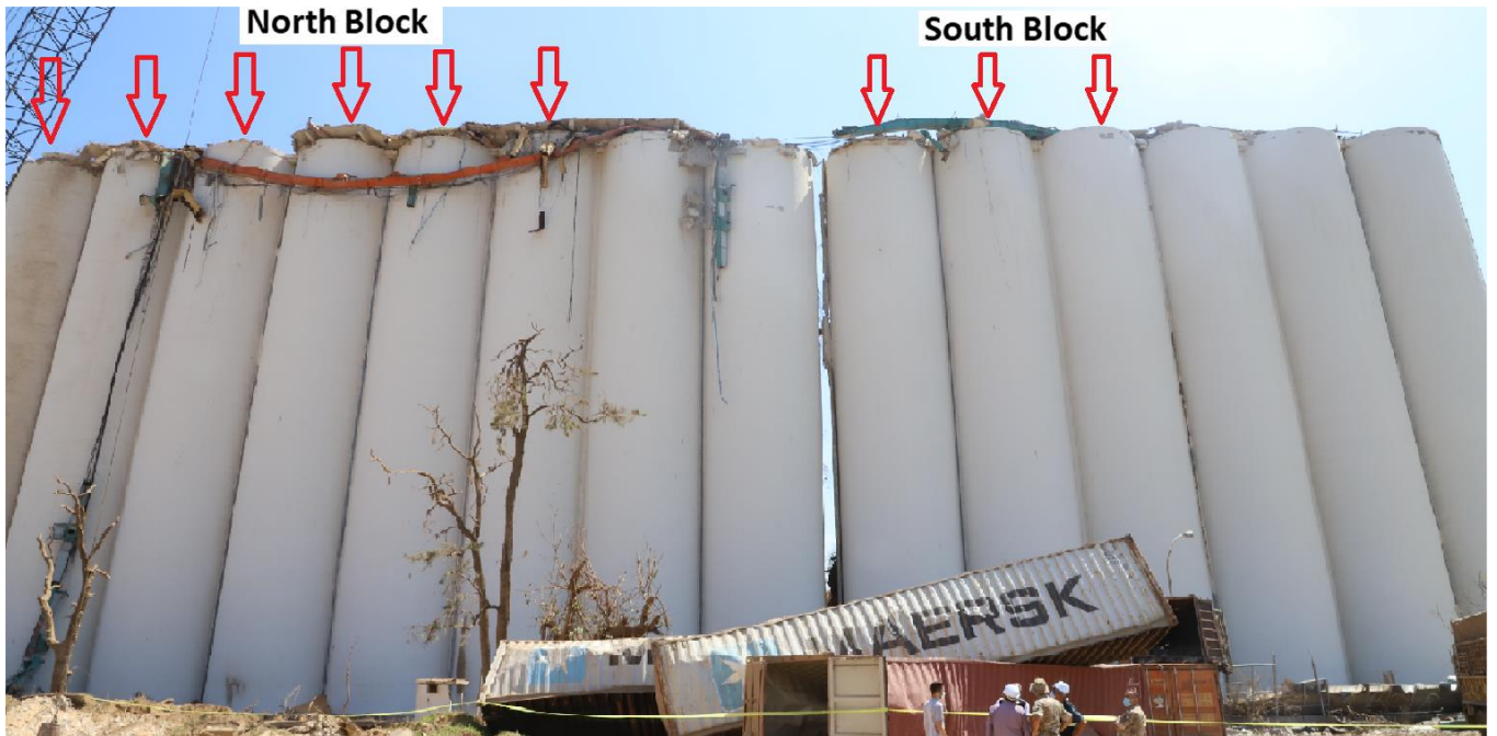
Figure 2. الصوامع الخلفية المحتوية على حبوب بعد الانفجار التي يشير إليها السهم والباقي فارغة.
